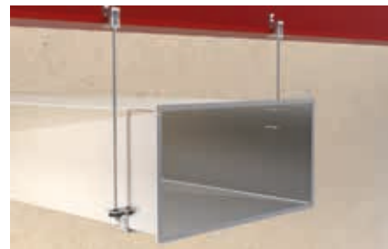
Conduit de ventilation suspendu
