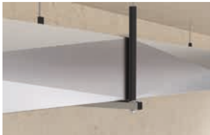
Fixation du conduit d'air avec rails
