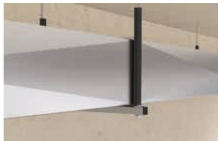
Fixation du conduit d'air avec rails
