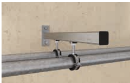
Fixation de tuyau le long d'un mur
