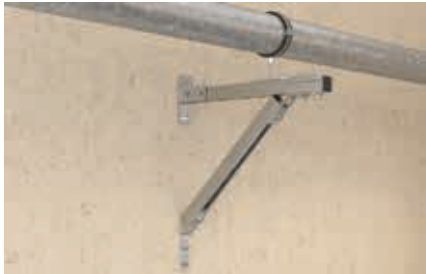
Tube acier sur console
