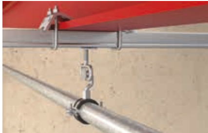
Rail sur poutrelle métallique
