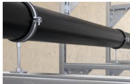
Fixation de tuyauteries sur rails
