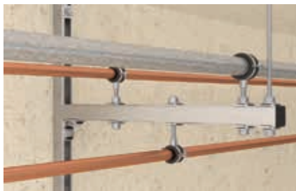
Construction en porte-à-faux avec rail
