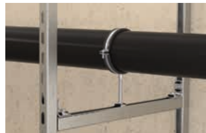
Fixation de tuyaux sur rails
