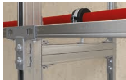
Construction de cadre pour tuyaux horizontaux
