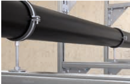
Fixation de tuyauteries sur rails
