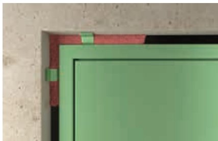
Calfeutrement d'ouverture
