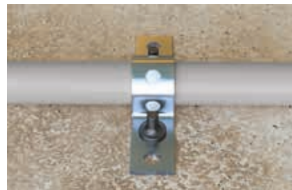
Fixation de bandes perforées
