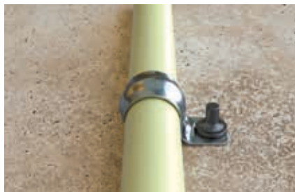
Fixation de conduites blindés
