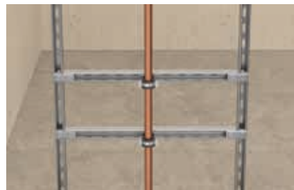
Structure à deux niveaux
