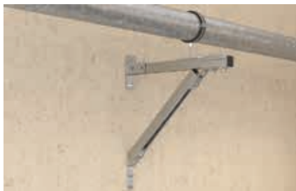
Tube acier sur console renforcée
