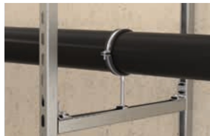
Fixation de tuyaux sur rails
