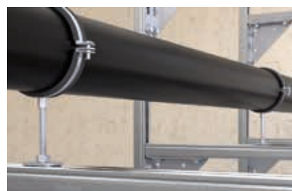
Fixation de tuyauteries sur rails
