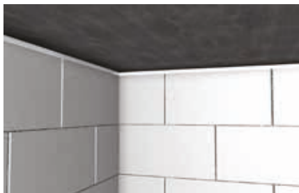
Joint de construction entre voiles
