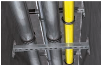
Fixation de tuyaux d'évacuation
