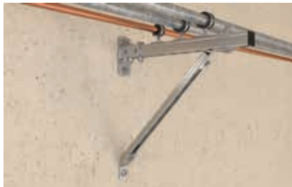
Montage léger de tubes sur console murale
