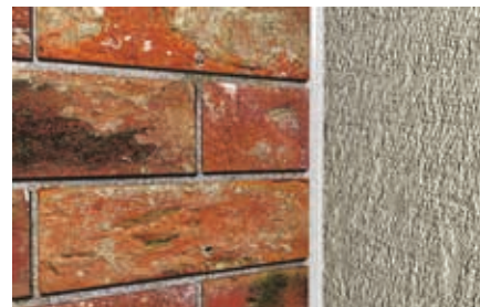
Joint de construction entre voiles
