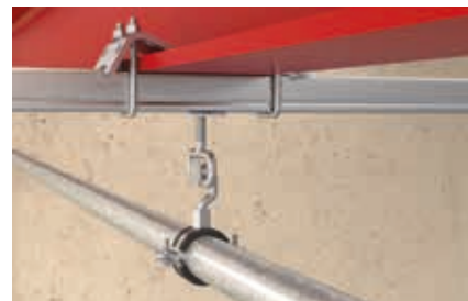
Rail sur poutrelle métallique
