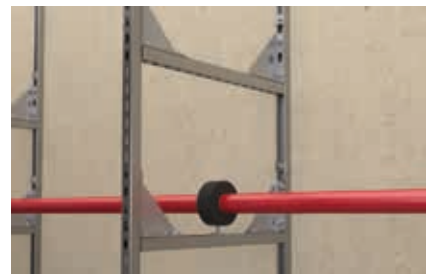
Construction stable d'ossature
