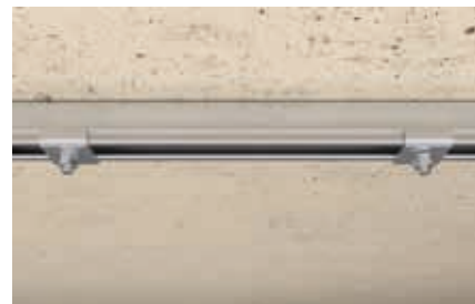
Installation de rails au mur
