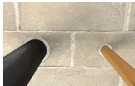
Calfeutrement de tuyauteries métalliques
