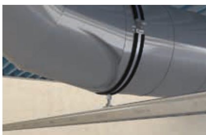
Structures portantes pour installations de ventilation
