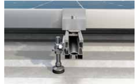
Toiture avec couverture en tôle ondulée
