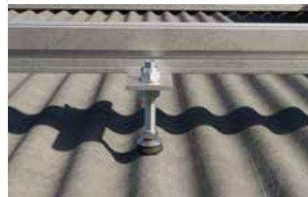
Toiture inclinée avec couverture en tôle ondulée
