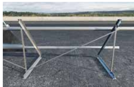
Triangulation sur toit plat
