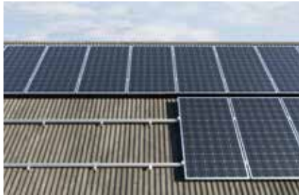
Toiture inclinée avec couverture en tôle ondulée
