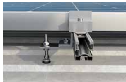
Toiture avec couverture en tôle ondulée
