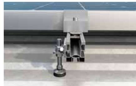
Toiture inclinée avec couverture en tôle trapézoïdale
