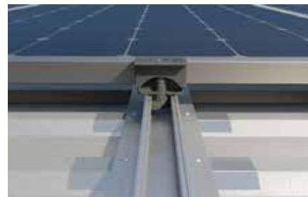
Couverture en tôle d'acier nervurée
