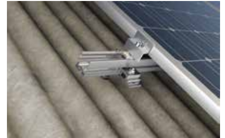
Toiture inclinée avec couverture en tôle trapézoïdale
