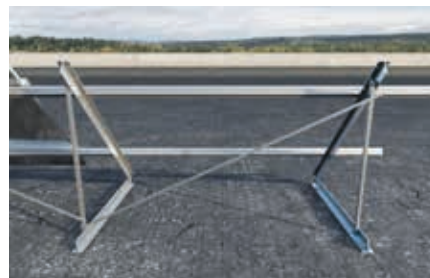
Triangulation sur toit plat
