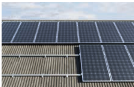
Toiture inclinée avec couverture en tôle ondulée
