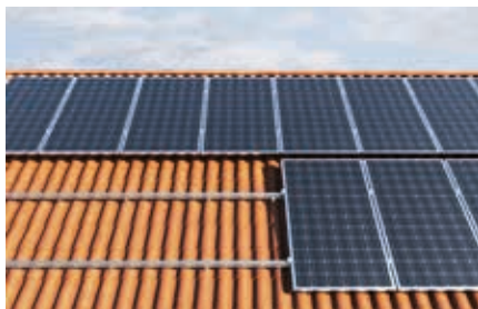
Toiture inclinée avec couverture en tuile canal
