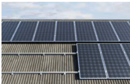
Toiture inclinée avec couverture en tôle ondulée
