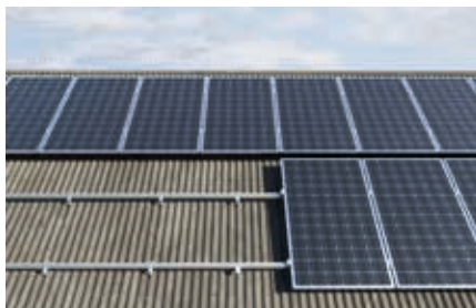
Toiture inclinée avec couverture en tôle ondulée
