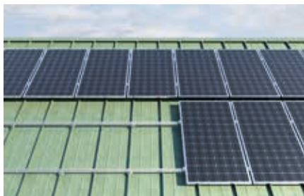
Toiture inclinée avec couverture en joint debout
