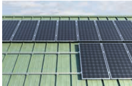
Toiture inclinée avec couverture en joint debout
