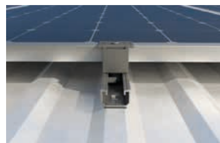
Couverture en tôle d'acier nervurée
