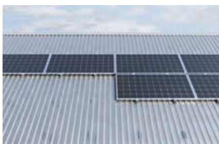
Couverture en tôle d'acier nervurée
