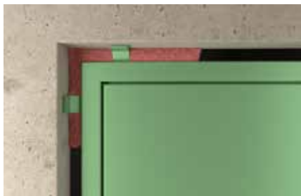
Calfeutrement d'ouverture
