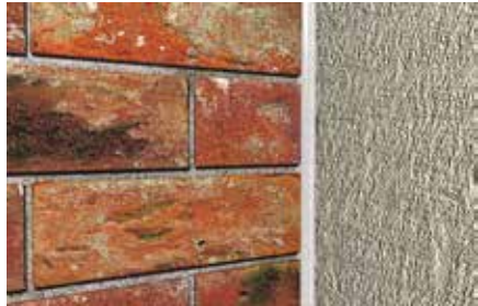
Joint de construction entre voiles
