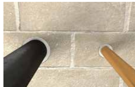
Calfeutrement de passage de tuyauteries métalliques
