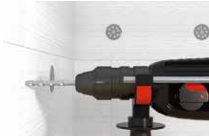
Fixation de panneaux isolants
