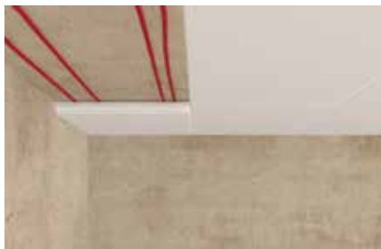
Panneaux d'isolation au plafond
