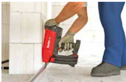
Pose de rails pour cloisons sèches
