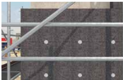
Isolants résistant à la compression sous enduit
