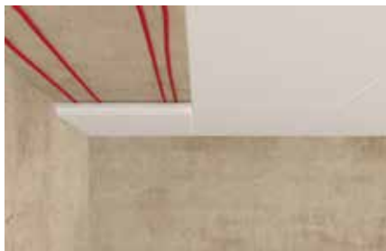
Panneaux d'isolation au plafond
