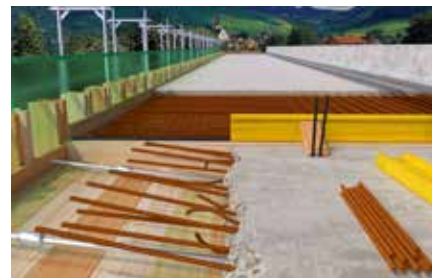
Fixation de fers à béton
