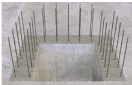
Scellements de fers à béton
