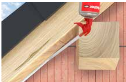
Remplissage et isolation des joints dans le domaine de la toiture
