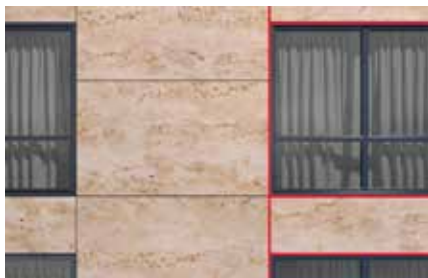
Joints d'étanchéité des panneaux de façade
