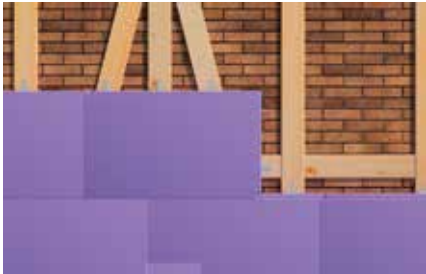
Panneaux isolants résistant à la compression sur ossature en bois
