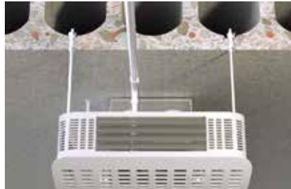
Climatiseurs dans les dalles alvéolaires
