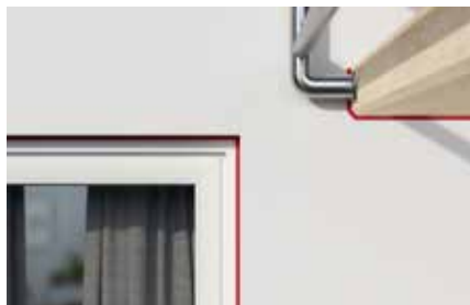
Joints de raccordement en extérieur
