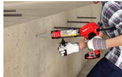
Reprise de fers à béton
