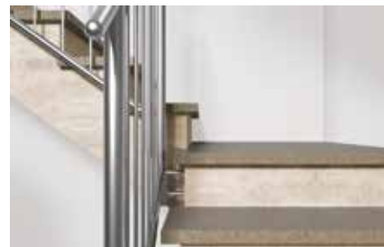
Marches d'escalier sur limons en béton
