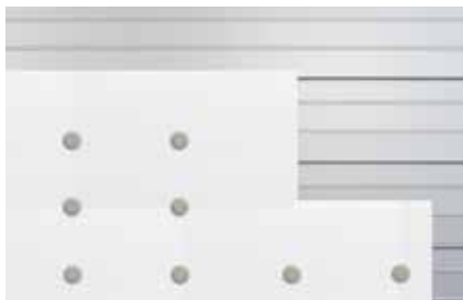
Panneaux de polystyrène sur tôle métallique
