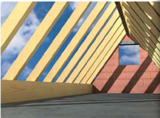
Fixation de pannes sablières
