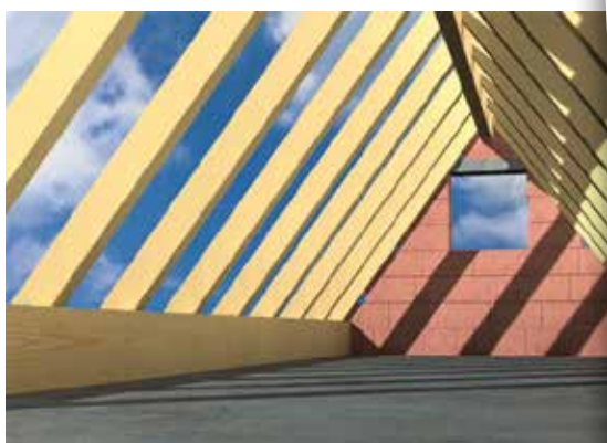
Fixation de pannes sablières
