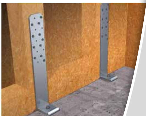
Fixation d'équerres sur chape béton
