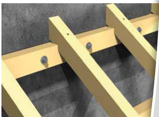
Fixation d'une muraille sur béton
