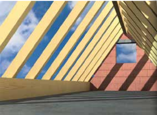
Fixation de pannes sablières
