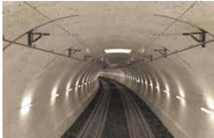
Tunnel de chemin de fer
