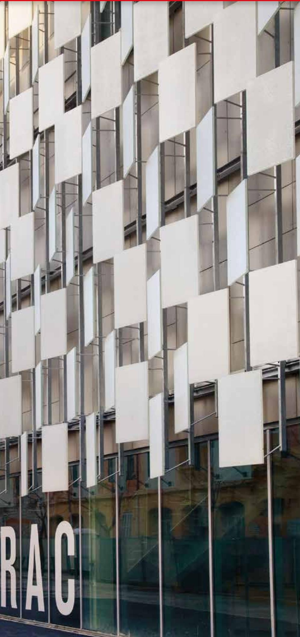
Il s'agit ici de la technologie fischer A|C|T et des inserts FZP II qui représentent tout un système de fixation de plaques pour façades ventilées. Ses caractéristiques uniques en font le système le plus polyvalent, transformant vos projets en réalité.
