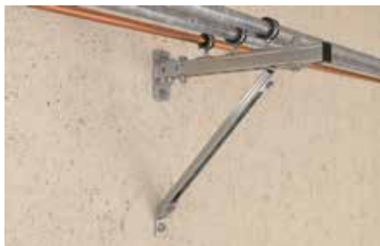
Montage léger de tubes sur console murale
