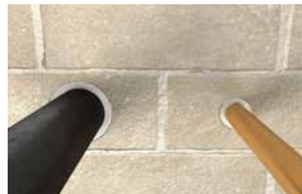
Calfeutrement de tuyauteries métalliques
