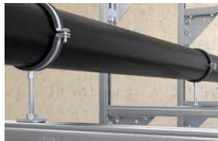
Fixation de tuyauteries sur rails
