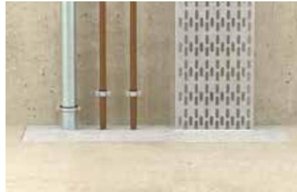
Pénétrations multiples à travers dalles
