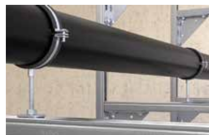
Fixation de tuyauteries sur rails
