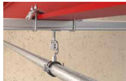
Rail sur poutrelle métallique
