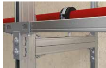
Construction de cadre pour tuyaux horizontaux
