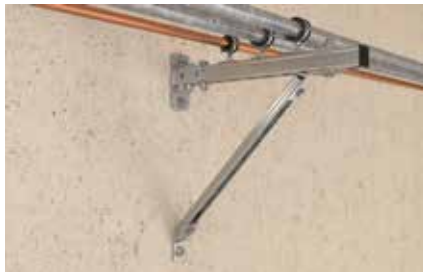
Montage léger de tubes sur console murale
