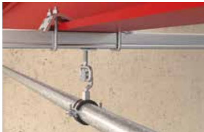
Rail sur poutrelle métallique
