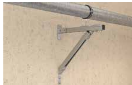
Tube acier sur console
