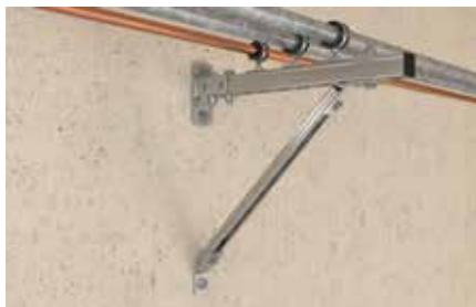
Montage léger de tubes sur console murale
