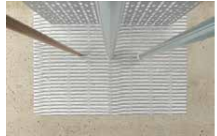
Pénétrations multiples à travers voiles
