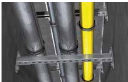
Fixation de tuyaux d'évacuation
