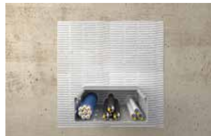
Application électrique en voile
