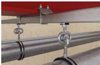
Fixation de rails sur poutrelles métalliques
