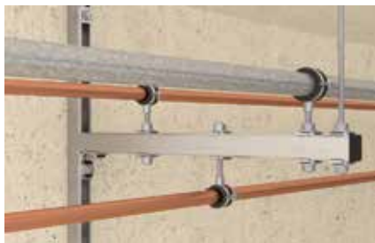
Construction en porte-à-faux
