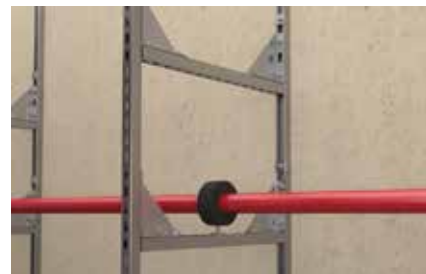
Construction stable d'ossature
