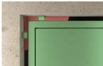
Calfeutrement d'ouverture
