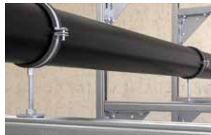
Fixation de tuyauteries sur rails
