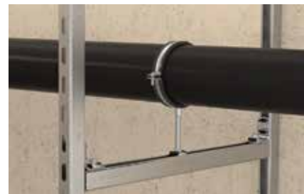
Fixation de tuyaux sur rails
