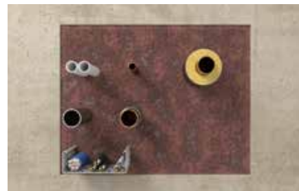
Pénétrations mixtes à travers voiles et dalles
