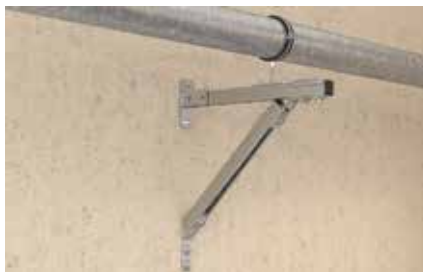
Tube acier sur console renforcée
