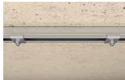
Installation de rails au mur
