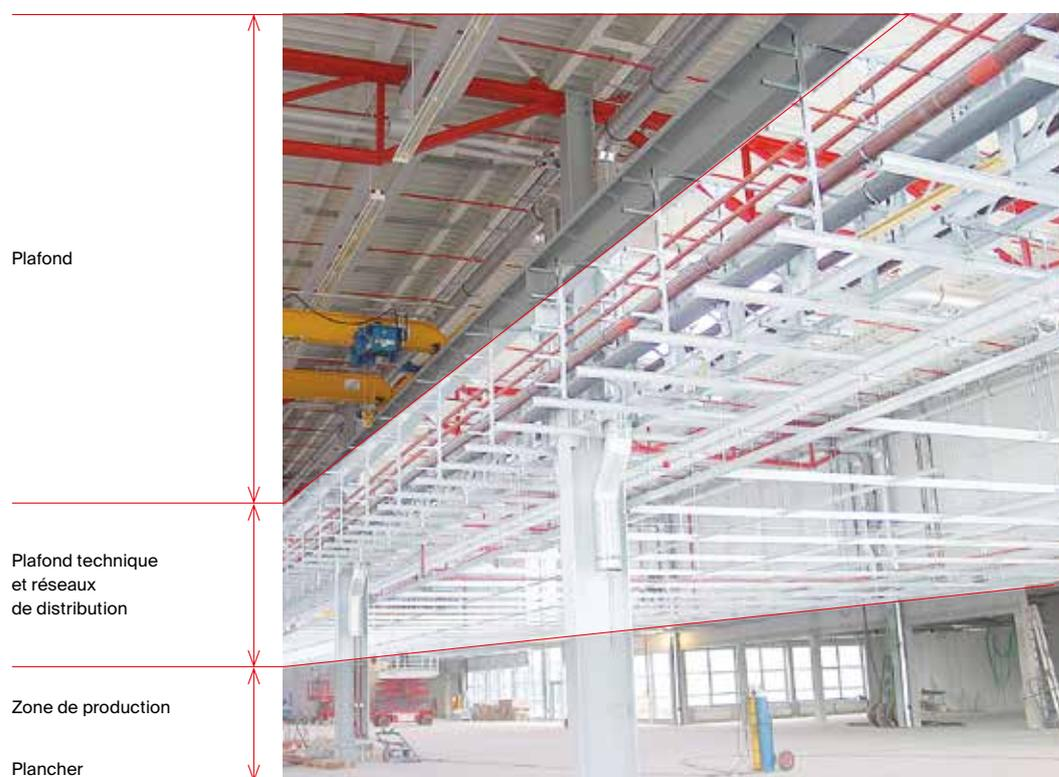
Un niveau séparé pour l'installation d'équipements intermédiaires est construit sous le plafond en utilisant un système de rails et d'éléments spécifiques de fixation provenant
