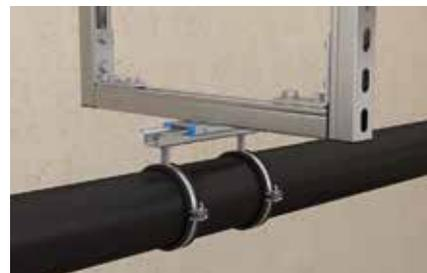
Système de dilatation avec coulisseau et tuyauterie suspendue
