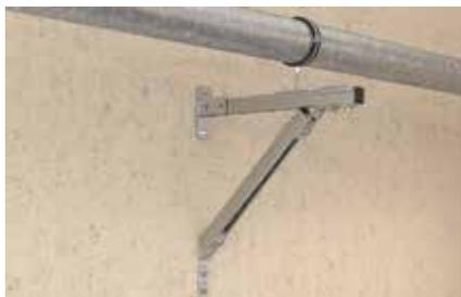
Tube acier sur console renforcée
