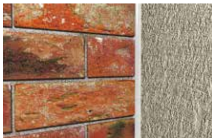
Joint de construction entre voiles
