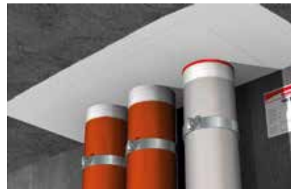
Passage de dalle
