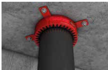
Passage de dalle
