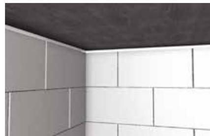
Joint de construction entre voile et dalle
