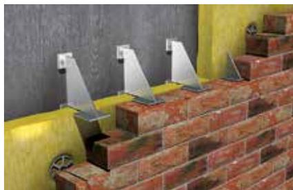
Matériau isolant pour mur à double paroi
