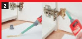
Extruder au moins quatre graduations ou 4 cm de mélange sur un papier. Injecter ensuite la résine dans la partie endommagée et la combler.
