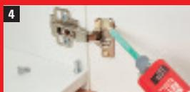
Si nécessaire, rajouter encore de la résine au travers du trou de vis de la charnière.
