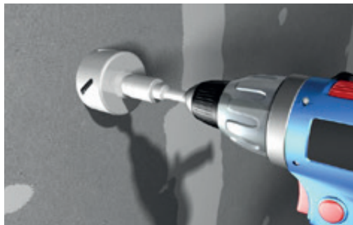
Perçage dans le plâtre
