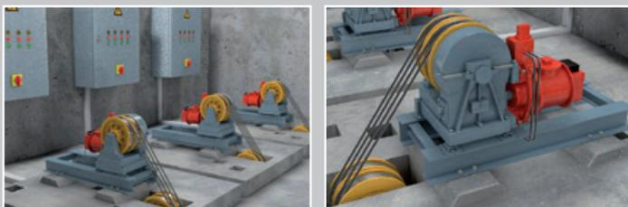
Les systèmes de motorisation doivent être fixés avec du chevillage lourd et homologué. Le choix se portera vers des systèmes chimiques ou mécaniques fiables et de hautes performances.
