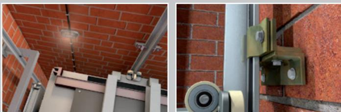
Le scellement chimique combiné aux bons accessoires garantit un transfert parfait des charges à la brique pleine ou creuse. Pour des charges réduites, il conviendra d'opter pour des fixations pour ossatures et cadres offrant de bonnes performances dans les blocs pleins.
