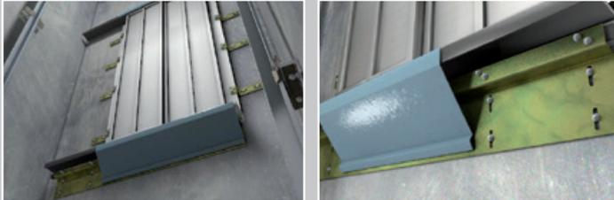
Les chevilles mécaniques à expansion offre des hautes performances même proche d'un bord libre. Ce critère se rencontre fréquemment dans la fixation des portes dans les cages d'ascenseurs. Les fixations sont disponibles avec différentes formes de tête pour une installation simple et en toute sécurité.
