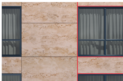
Joint d'étanchéité des panneaux de façade
