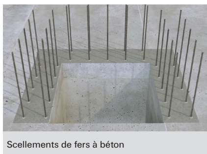
Scellements de fers à béton
